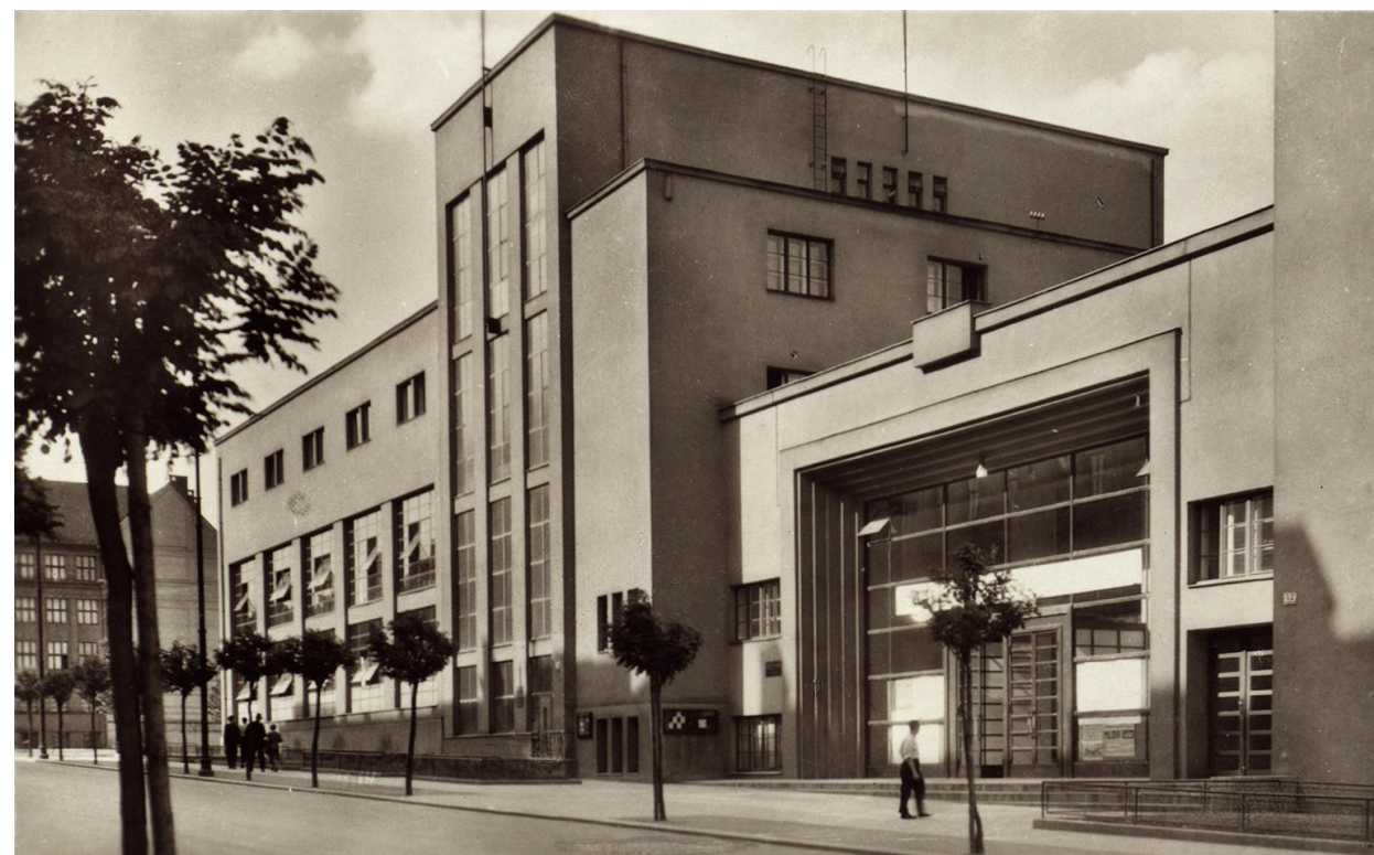
32 - Pohled ke vstupu na Stadion, nedatováno (30. léta)
