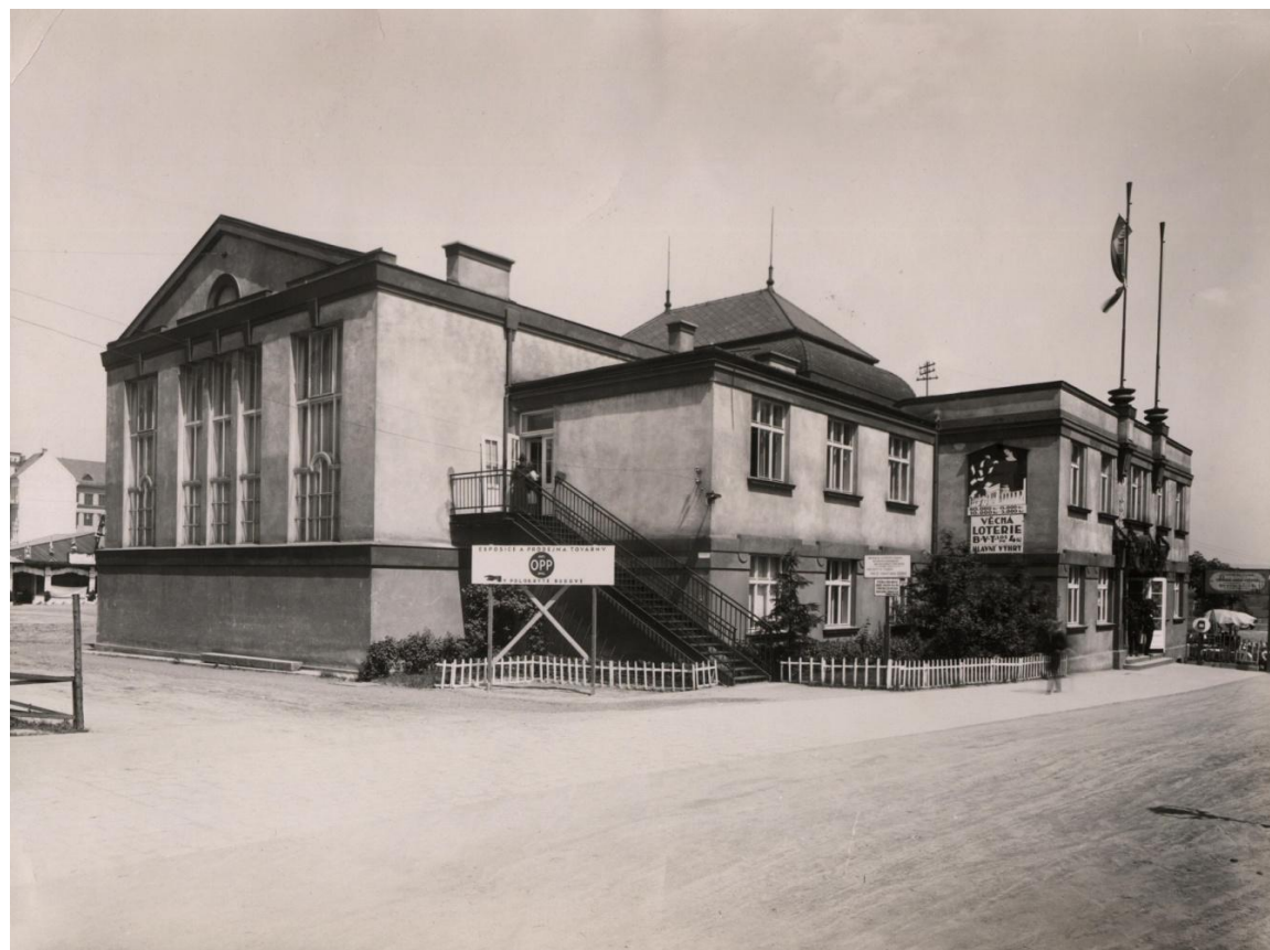
24 - Pohled na pavilon BVT, 1926
