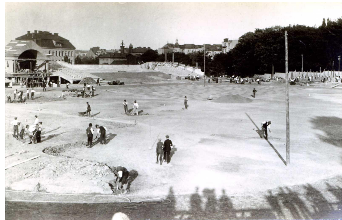
26 - Celkový pohled na stavenišťe, bez bližší datace 1922
