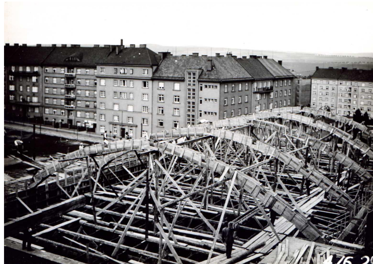
20 - Konstrukce pro střechu tělocvičny mužů, 4. červen 1929
