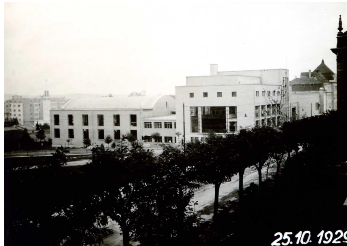
22 - Celkový pohled na stavbu, 25. říjen 1929
