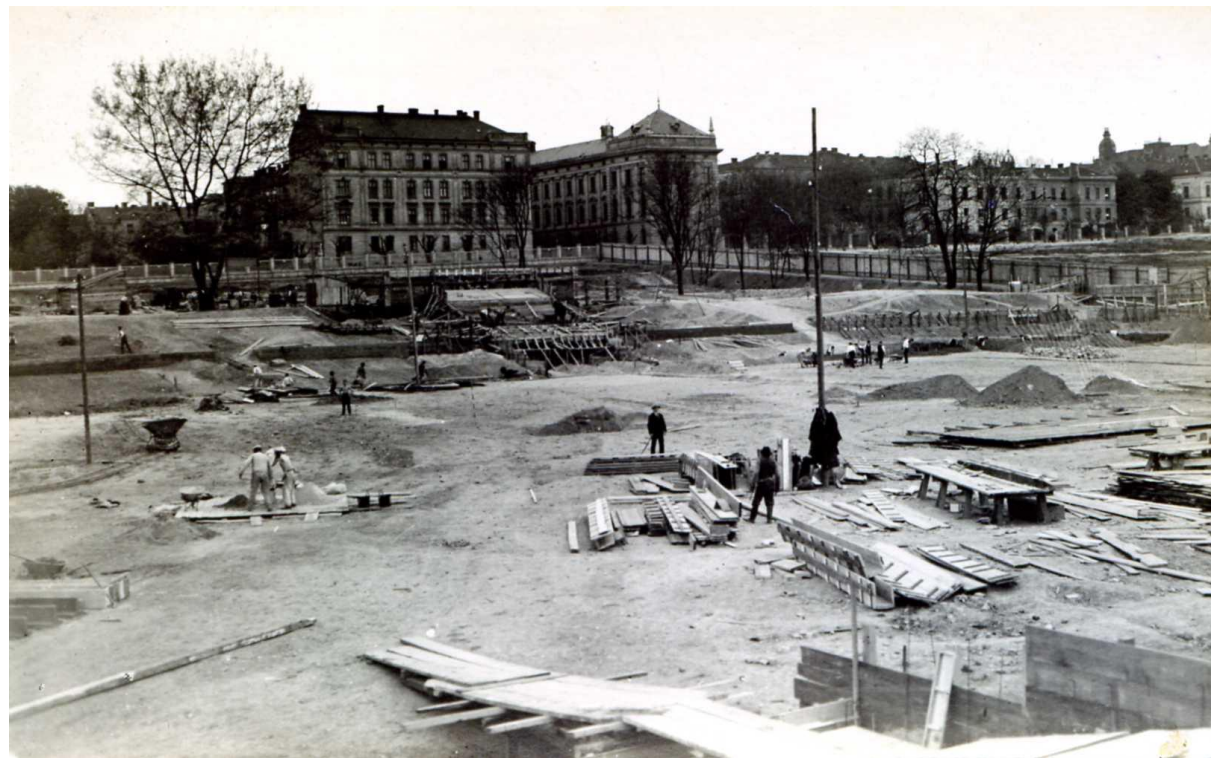
27 - Celkový pohled na stavenišťe, bez bližší datace 1922
