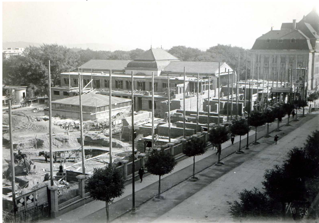
5 - Celkový pohled na stavbu, 7. říjen 1928
