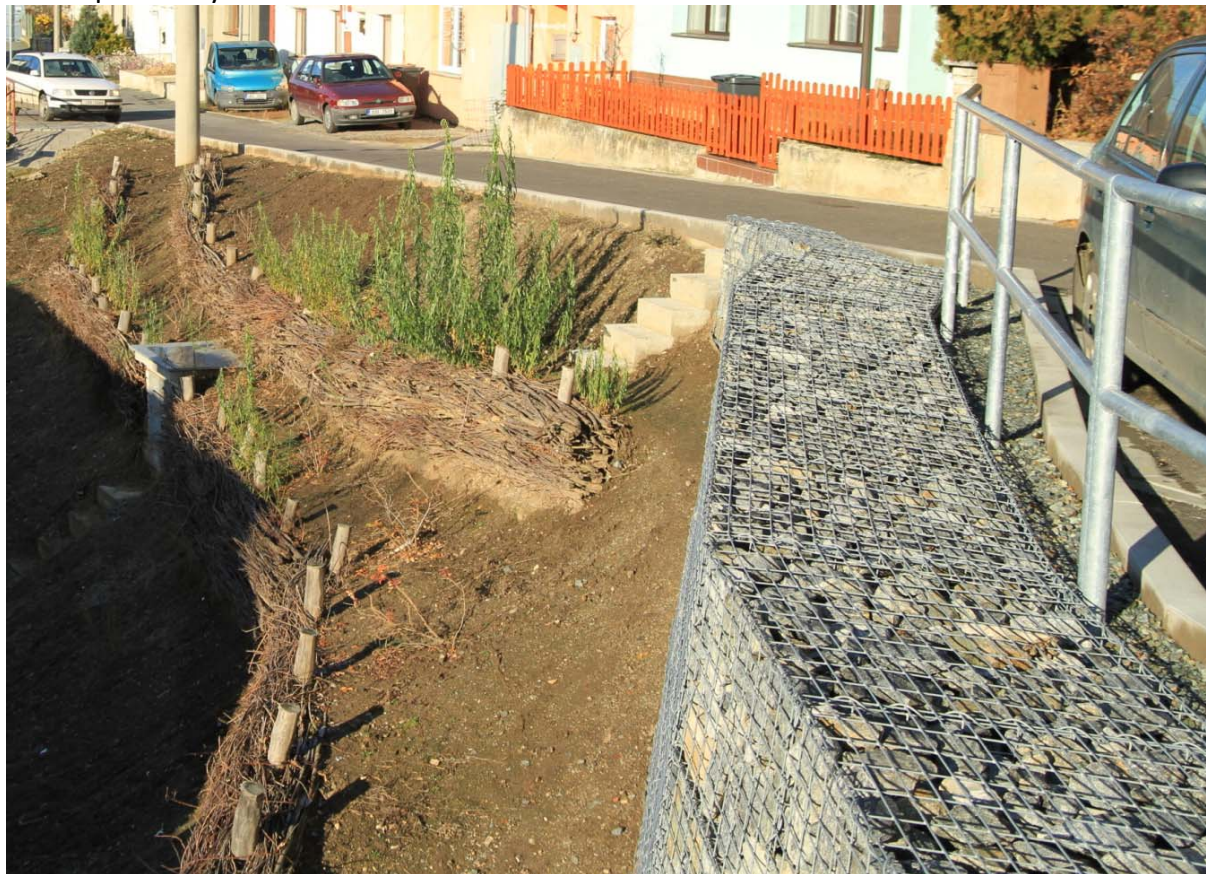
Obrázek 5: Příklad provedení dřevěné haťové konstrukce jako hlavní protierozní ochrana strmého svahu, stavba zajištění svahu ulice Antonínská, Dolní Kounice, 2016
