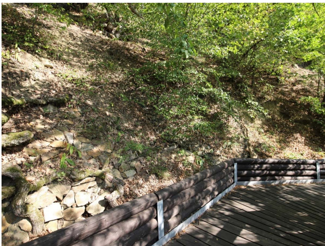
Obrázek 31: příklad zpevnění paty svahu kamennou rovinou a vpravo textilní sítí, km 0,610 – 0,617
