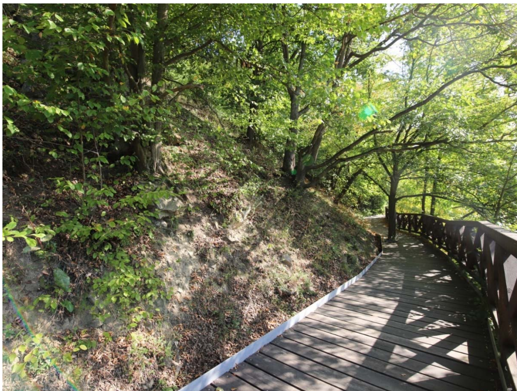
Obrázek 37: pohled na povahu terénu a svahů nad stezkou v km 0,655 – 0,680
