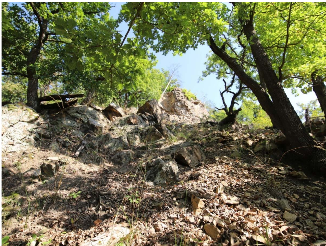
Obrázek 22: pohled na struktury suti na strmém svahu, svah nemá přirozenou záchytnou schopnost
