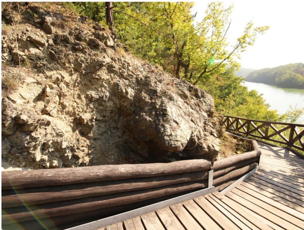
Obrázek 12: pohled na zcela odloučený labilní blok, který zatěžuje konstrukci stezky v km 0,521
