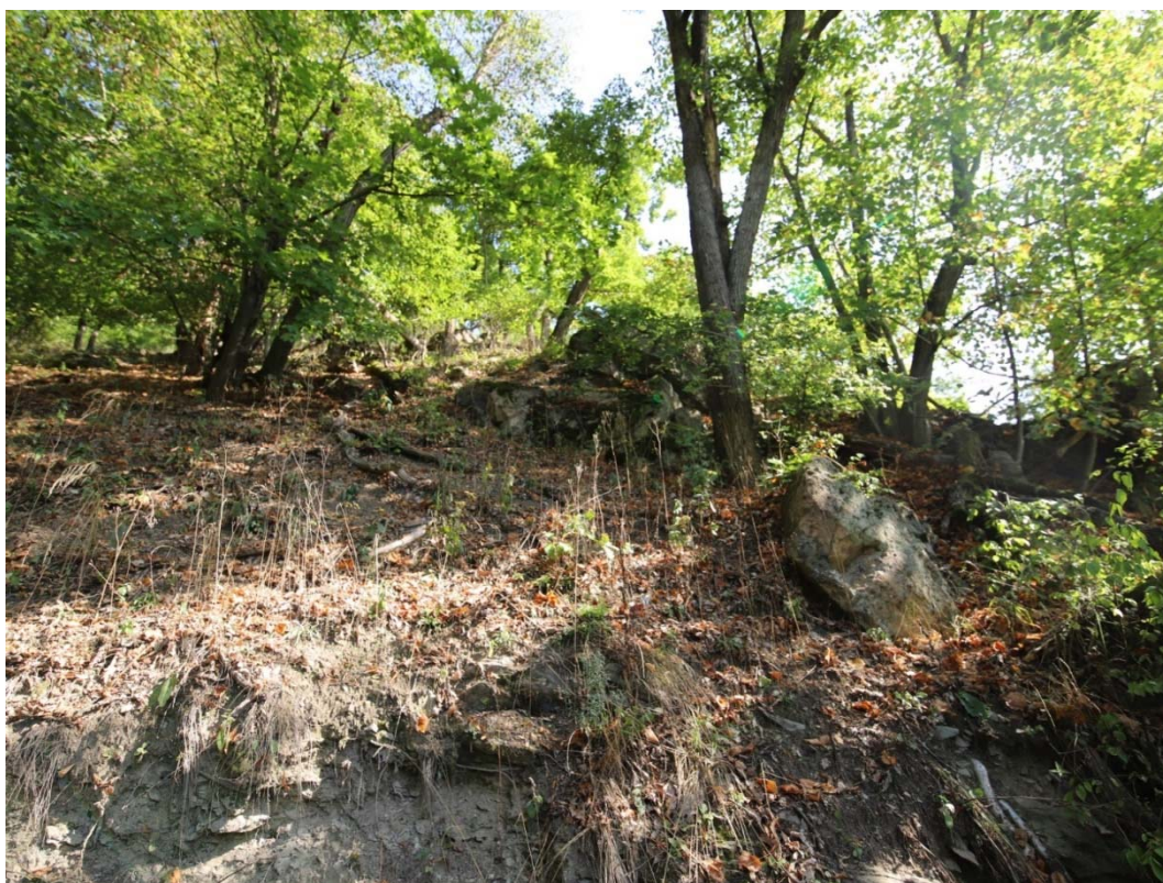
Obrázek 19: povaha a strmost svahu v km 0,575 – 0,580 s rizikovými bloky
