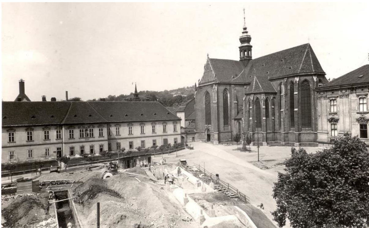
Obr. 6 – Budování chodbovitých protiletckých krytů během druhé světové války, zdroj. NPU u.o.p. Brno
