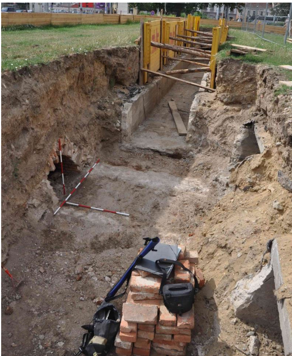
Obr. 18 – Chodba válečného protiletceckého krytu a novodobá betonová chránička inženýrských sítí při archeologickém výzkumu vyvolaném rekonstrukcí plynovodu a horkovodu, zdroj. Archiv Muzea města Brna
