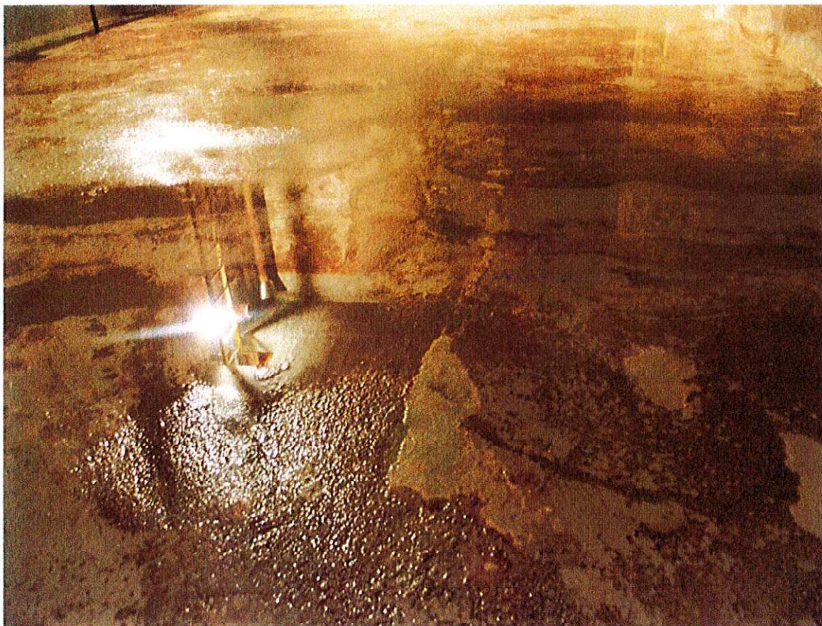
Detail dna – změkklý zdegenerovaný povrch
