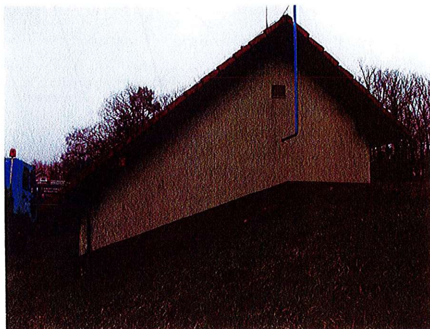
Exteriér vstupní komory
