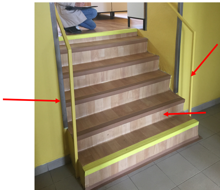
Schodiště v 1np v úrovni nejnižší podesty chodby – bude odstraněna nášlapná vrstva, zábradlí a rohové lišty ostění
