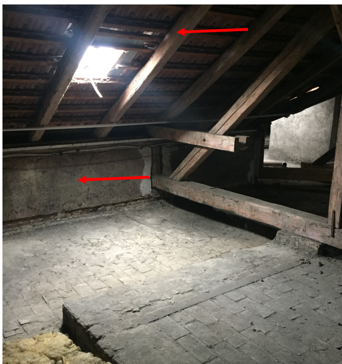
Půda nad schodištěm u budoucího výstupu z výtahu – bude odstraněna krytina z keramických pálených tašek, parapet z CPP a pozednice, část dřevěných krokví a skladba podlahy v ploše cca 5 x 2,85 m
