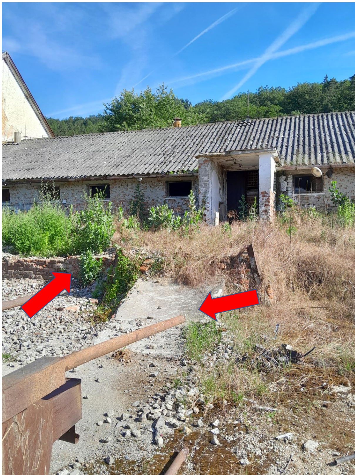
3 – betonový nájezd + část zděné zídky
