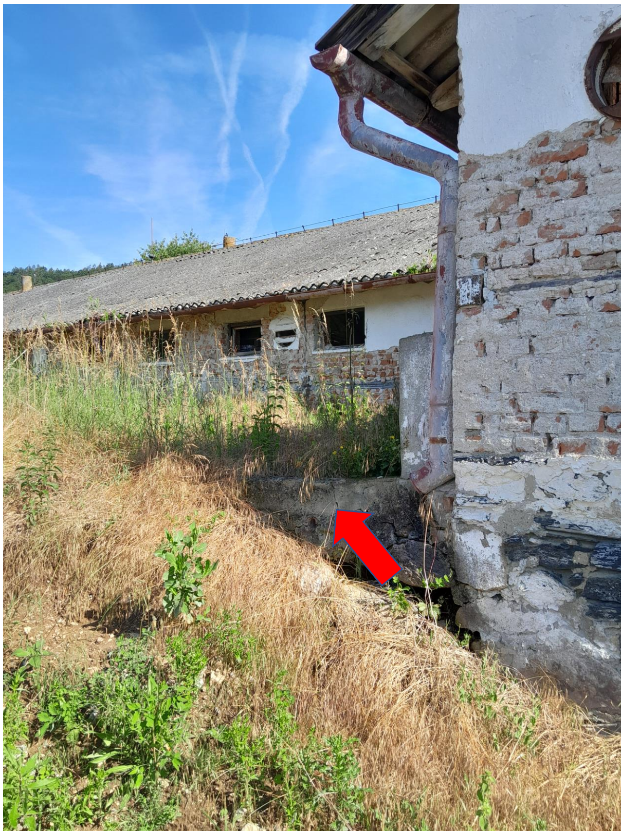
4 – část opěrné zídky
