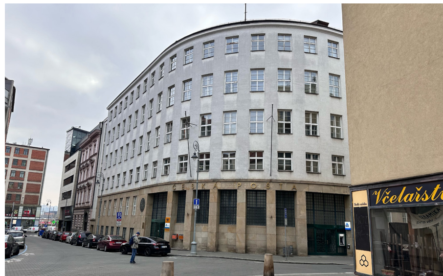
02 Pohled na nároží budovy (západní)
