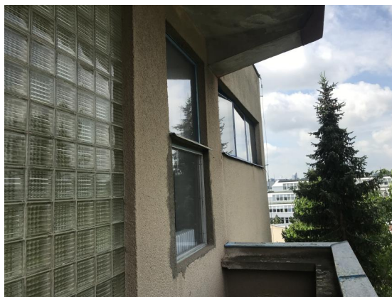
okenní element 6, 2.NP. Nepůvodní hliníkové okno na místě vyklápěcího okna.
