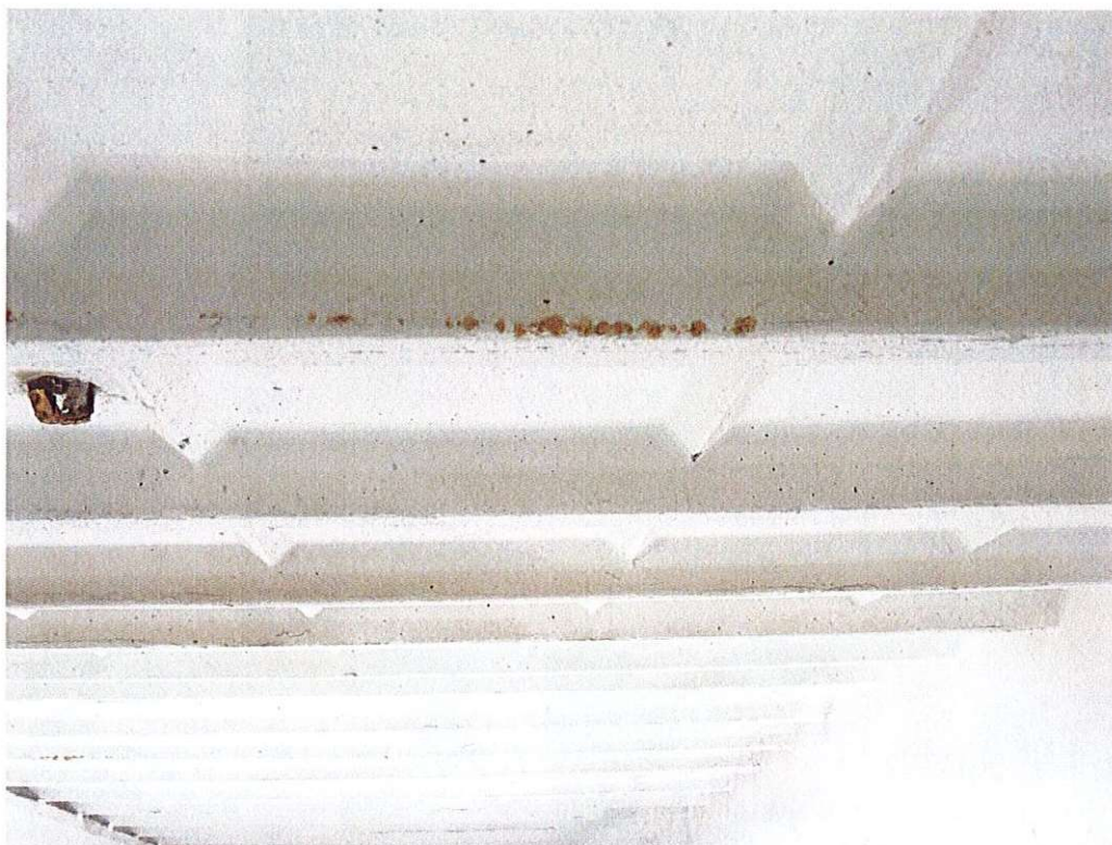
Žebírkové panely – probíhá koroze nosné výztuže, která je téměř nemožná sanovat
