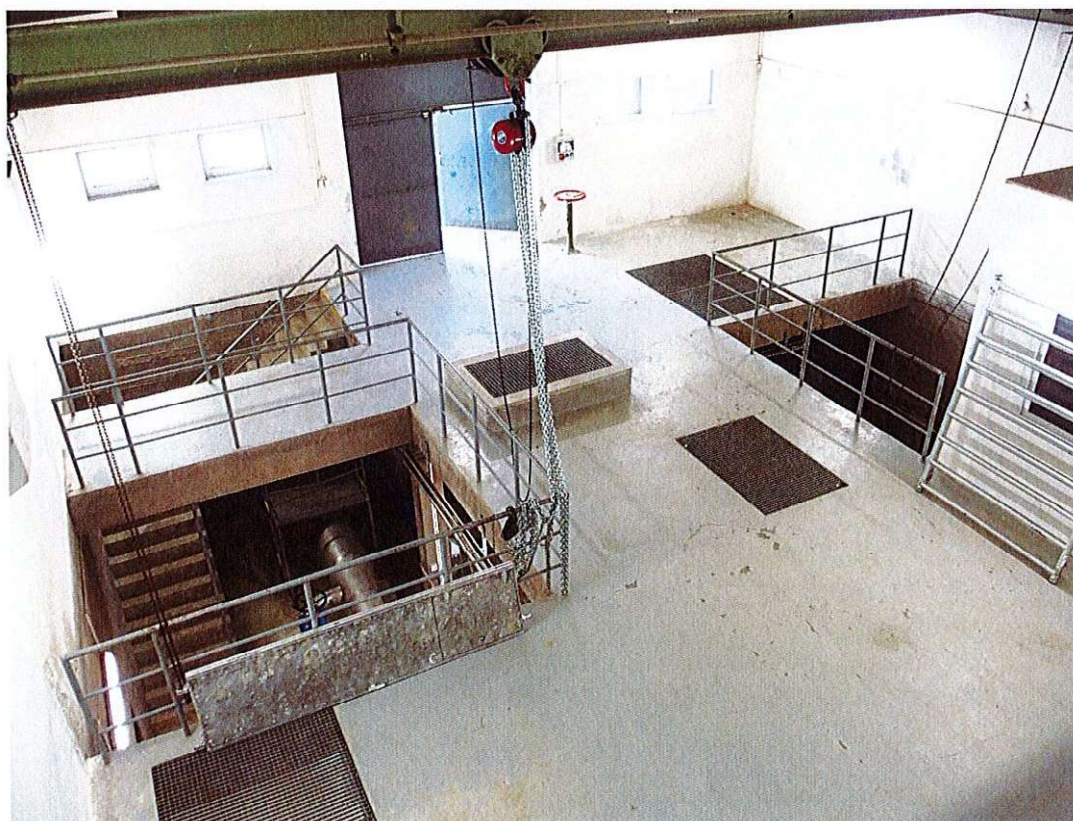
Celkový pohled na přízemí vstupní komory
