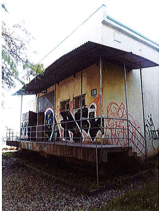
Celkový pohled na obslužnou rampu a přístřešek nad ní
