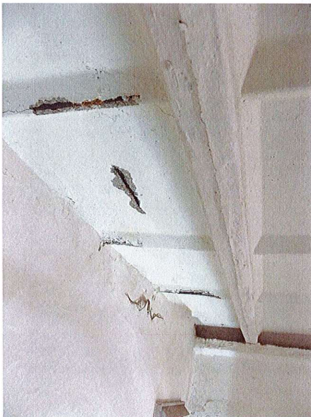
Žebírkové panely – probíhá koroze nosné výztuže, která je téměř nemožná sanovat
