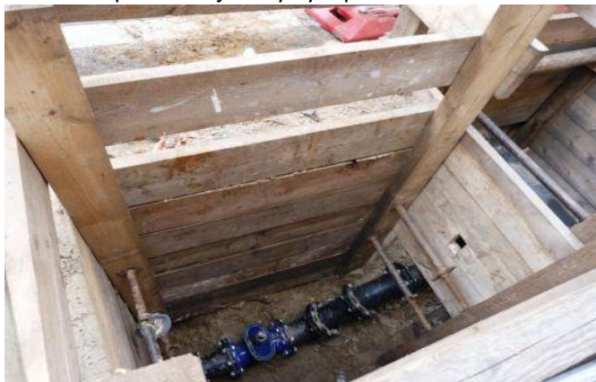
obr. 8 správně zajištěný výkop
