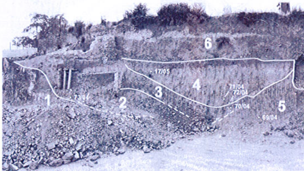
Obr. 2. Západní stěna stavebního výkopu na Kopečné ulici v Brně s vyznačením vzorků a hominových těles: 1 – metabazit brněnského masívu, 2 – vápnité jily („těgely“) spodního badenu, 3 – gravitačně deformovaná zóna jílu s tenkými čočkami písku, 4 – tělo sesuvu tvořené vápnitými jilami karpátu, 5 – makroskopicky neporušené vápnité jily karpátu, 6 – antropogén (navážky, morové jámy). Foto: M. Bubík.
