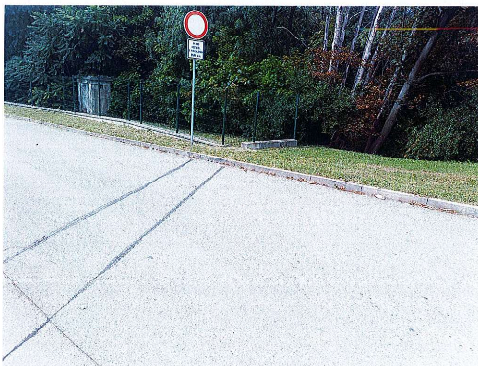
Obr. 4 Pohled na stávající stav sjezdu, na fotografii je viditelné zařezány spáry a zality asfaltovou modifikovanou zálivkou – příprava pro plánované osazení nové pásové vpusti v rámci dílčího stavebního objektu, v pozadí stávající protipovodňová stěna a pak řeka Svratka
