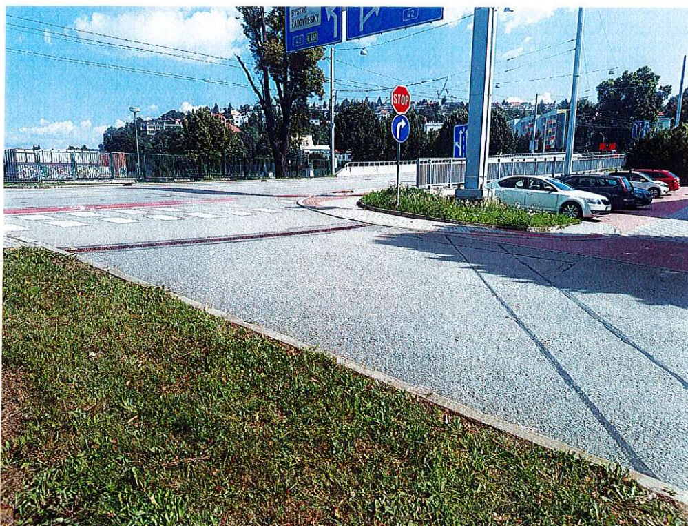
Obr. 3 Pohled na stávající stav sjezdu, v pozadí stávající pásová vpusť, jež zůstane zachována, vpravo zařezány spáry a zality asfaltovou modifikovanou zálivkou – příprava pro plánované osazení nové pásové vpusti v rámci dílčího stavebního objektu
