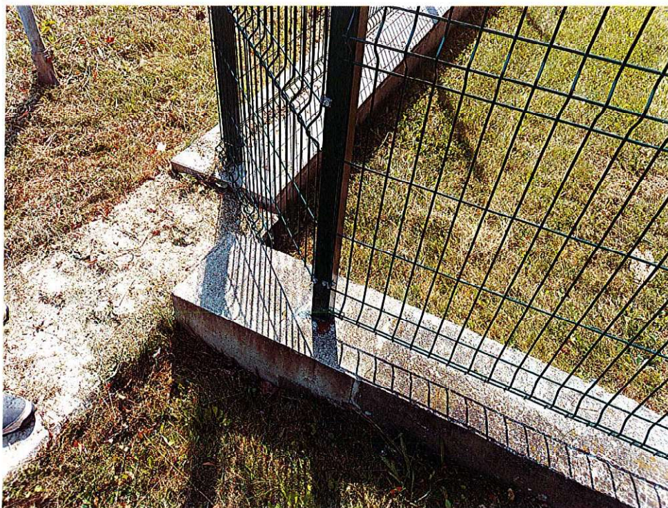
Obr. 5 Detailní pohled na stávající protipovodňovou stěnu
