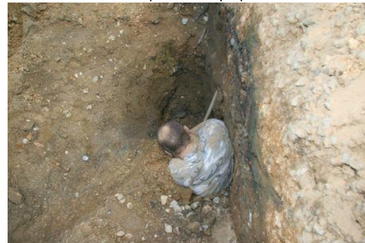
obr. 9 důsledek nezapaženého výkopu
