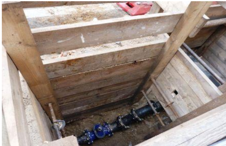
obr. 8 správně zajištěný výkop
