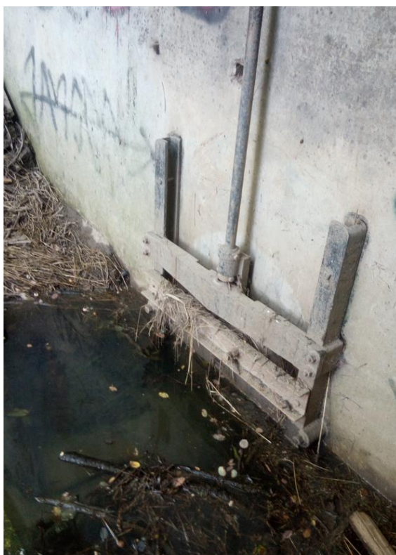
Obr. 11 Hráz RN Řečkovice – uzávěr spodní výpusti
