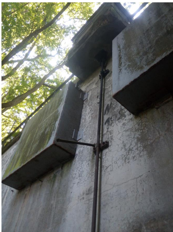
Obr. 12 Hráz RN Řečkovice – bezpečnostní přelivy/savky
