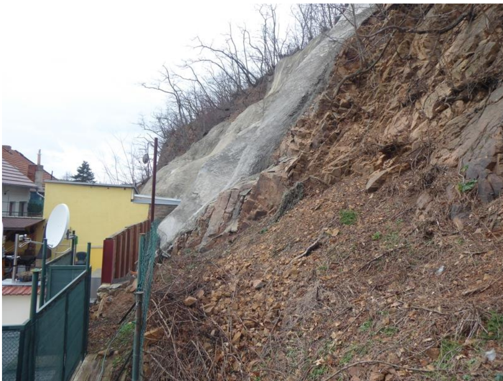
Skalní stěna za domem č. 58 s velkým množstvím opadáných kamenů v akumulační oblasti. Svah za sousedním domem č. 60 již byl sanován stříkaným betonem.
