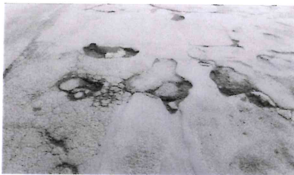
HI. koroze, výtluky, vysprávký, mozaikové trhliny
