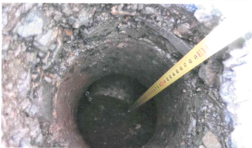
Dutina pod silničním panelem zastižená v místě sondy S 3
