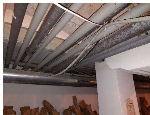
Obr. 2 25 – Kabely uchycené na trubkách 1.PP
