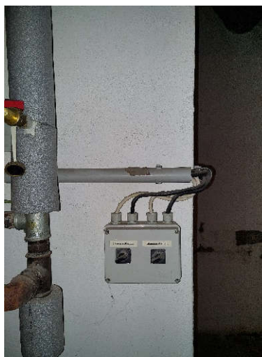
Obr. 16 39 – Ruční řízení čerpadel VZT
