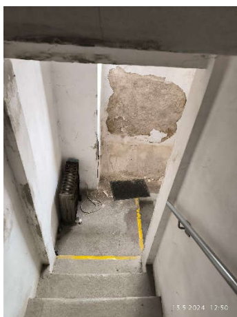
Obr. 5 – Stopy po pronikání vlhkosti
