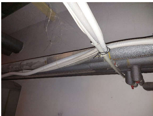
Obr. 3 26 – Uchycení kabelů 1.PP
