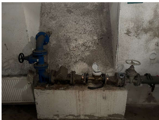
Obr. 1 14 – Vodoměrná sestava
