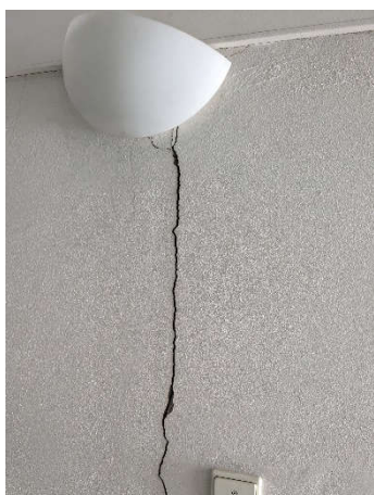
Obr. 3 - Praskliny ve schodišťovém traktu
