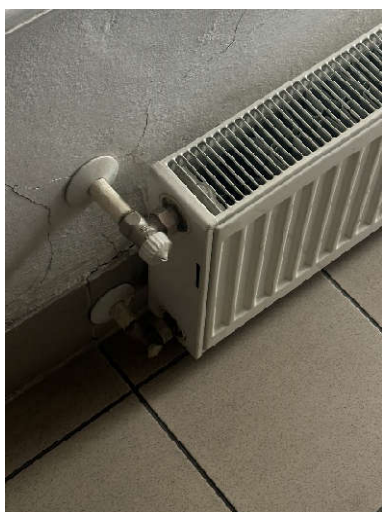
Obr. 5 18 – Chybějící termostatické hlavice
