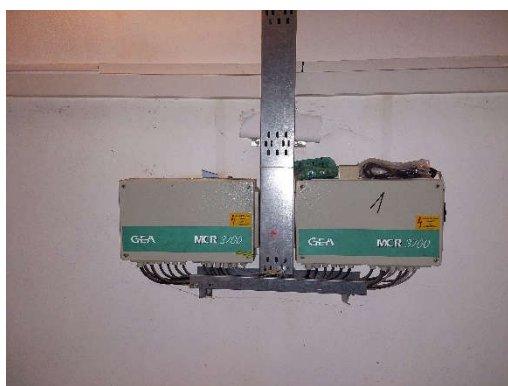
Obr. 17 40 – Řídicí systém VZT
