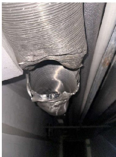
Obr. 10 23 – Poškozená pružná hadice rozvodů VZT
