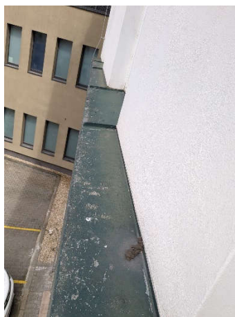
Obr. 6 -13 Zášlý nátěr na TiZn oplechování říms do dvora
