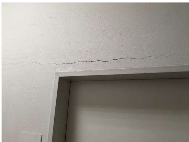
Obr. 1 -8 Praskliny v dělicích příchách
