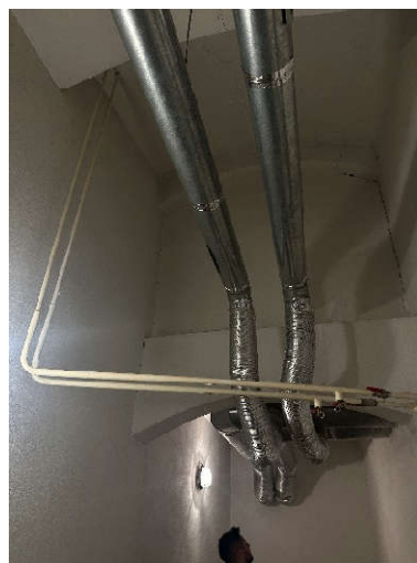
Obr. 4 17 – Nedostatečné uchycení rozvodů topné vody
