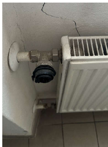
Obr. 6 19 – Chybějící termostatické hlavice
