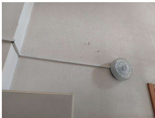
Obr. 4 27 – Rozvod v liště a svítidlo vrátnice
